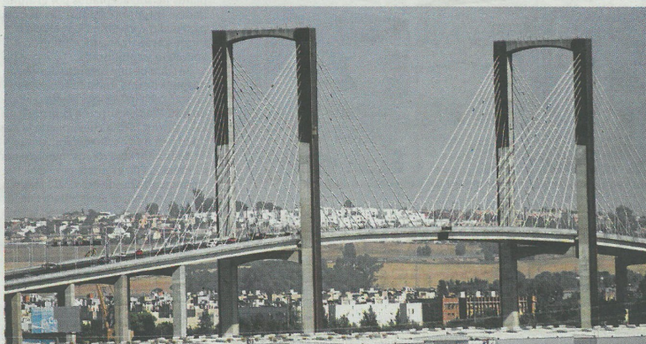
El puente del Centenario es el tramo más problemático de la SE-30
