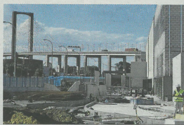
Obras del centro comercial junto al Centenario a finales de mayo.
